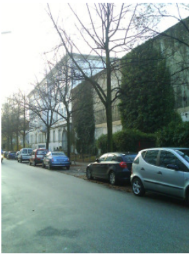
Bunker in der Humboldtstraße © Foto Oliver Trede
