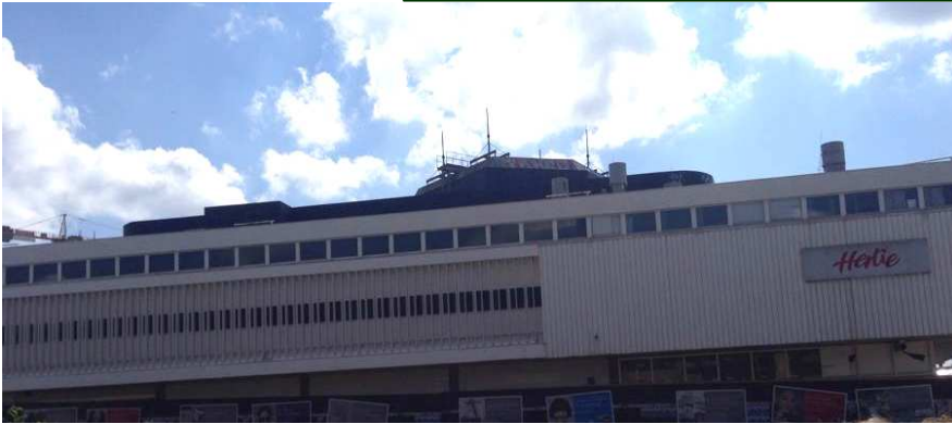
Ein letzter Blick auf das alte Hertie-Gebäude. Foto: Rüdiger Wendt
